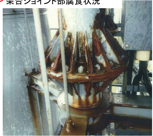
架台柱部腐食状況
